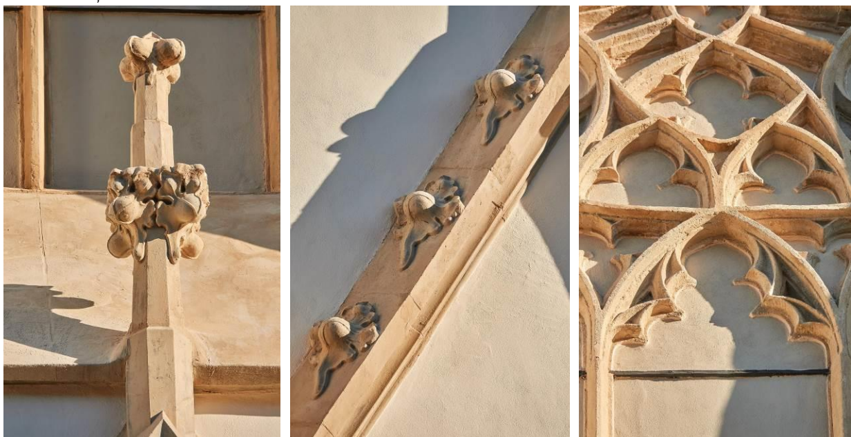
Detaliu – componente de piatră de pe fațada de Vest
