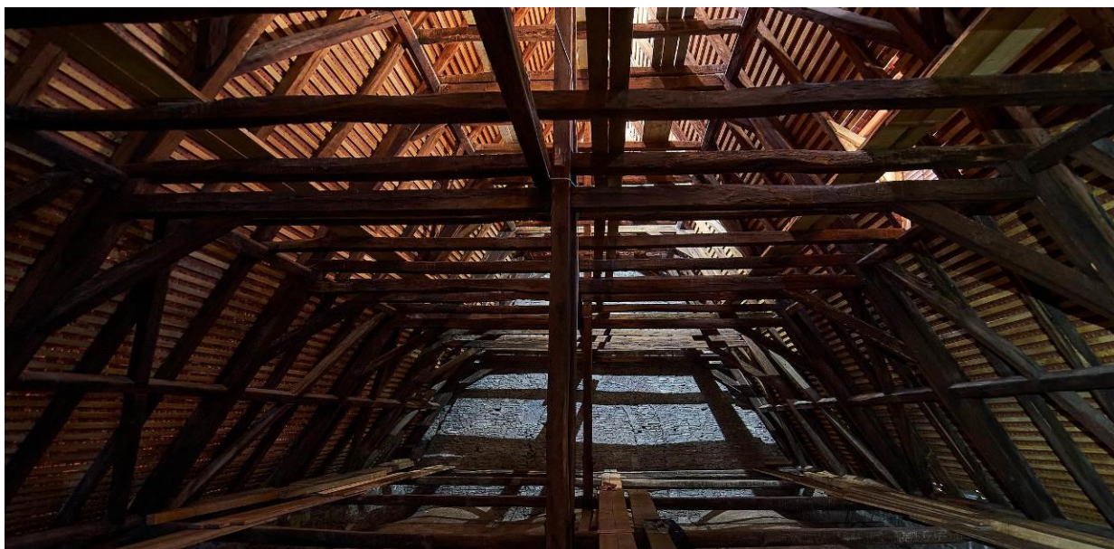
Șarpanta istorică barocă – peste navă
