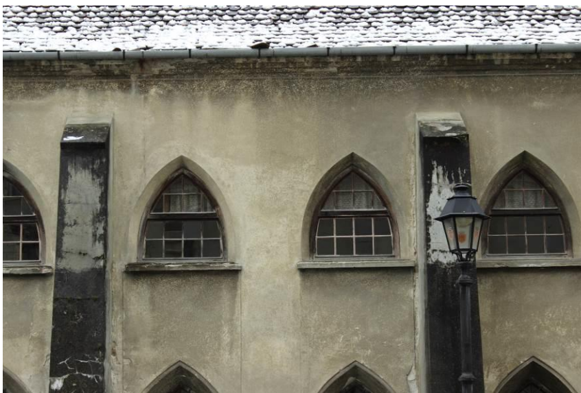
Ferestre - Façada de Nord înainte de restaurare
