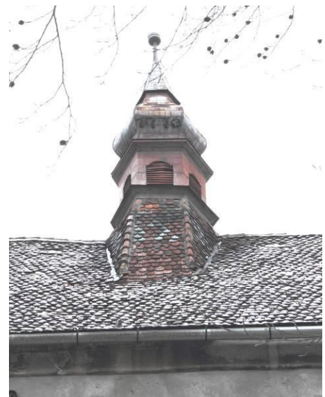
Lanternou - Façada de Sud
