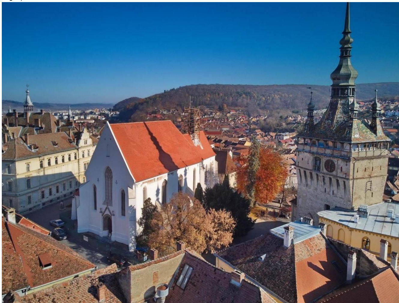
Vedere de ansamblu – fațada de Sud-Vest
