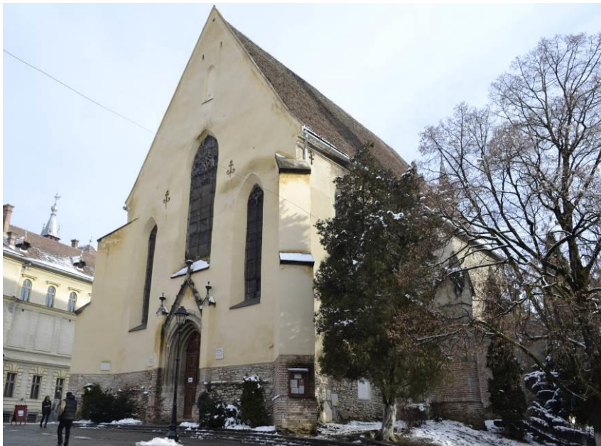
Façada de Est înainte de restaurare
