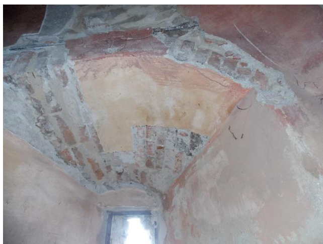
Foto nr. 2: Arc consolidat prin împănare, matare, injectare
