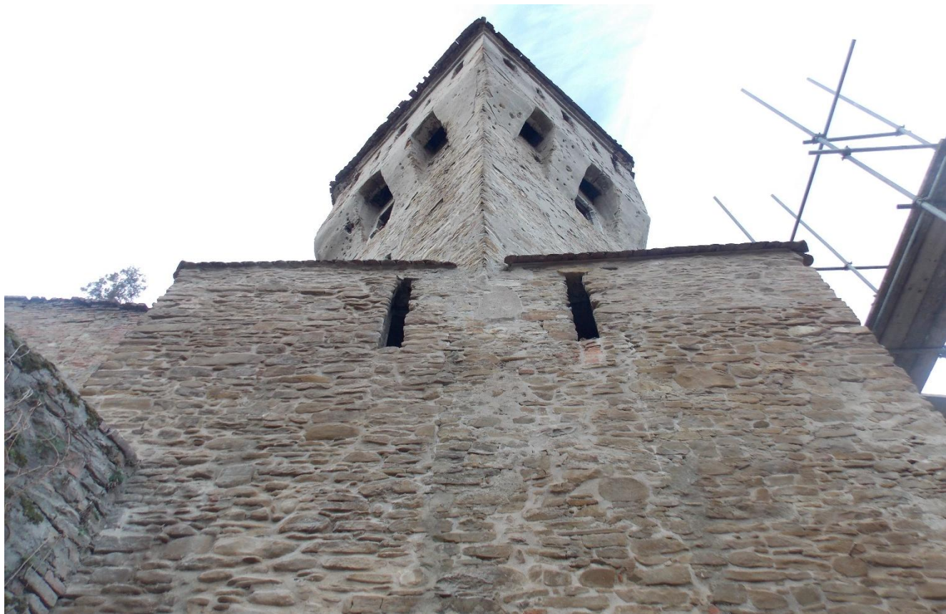
Foto nr. 1: Fațada estică consolidată după demontarea schelei
