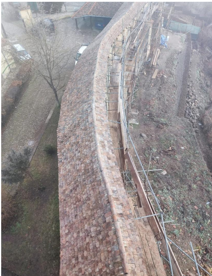
... und das fertige Dach (aus der Perspektive des Zinngießer-Turmes)
